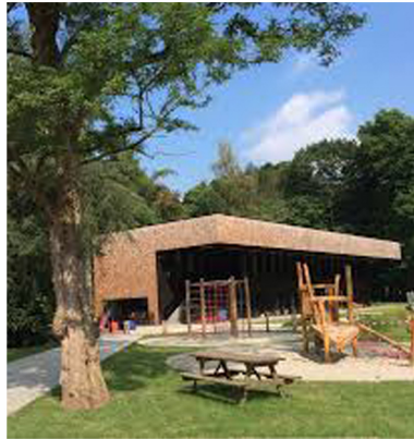
Omgevingswerken Zonnekind, Kalmthout ARA ism Land / B-Architecten (technische uitwerking)
